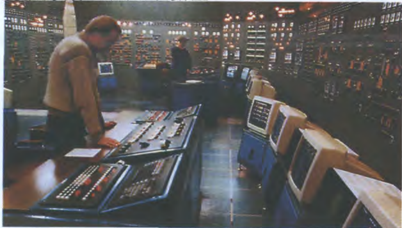
俄罗斯巴拉科沃培训中心的一台用于培训核电厂运行人员的全尺寸模拟器。来源：美国能源部
