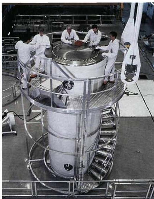
Instalación de almacenamiento de combustible gastado en Oikiluto, Finlandia. (Cortesía: TVO)
