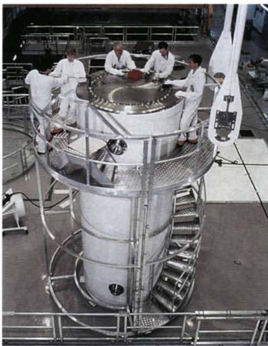
Installation de stockage du combustible irradié à Oikiluto en Finlande. (Photo: TVO)
