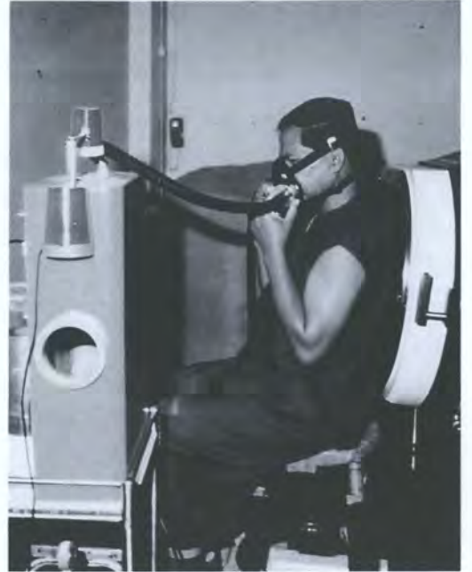
在 IAEA 资助的空气污染研究工作中,受试者吸入放射性标记的气溶胶,以测量其肺的渗透性。
