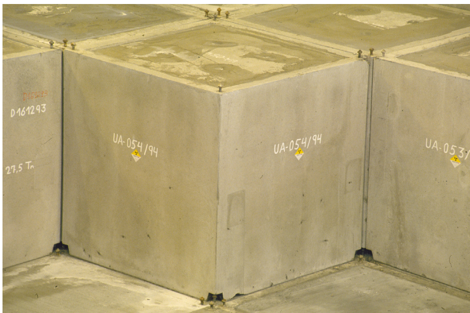
Detalle de contenedores para el almacenamiento de RBMA en las celdas de almacenamiento de El Cabril.
