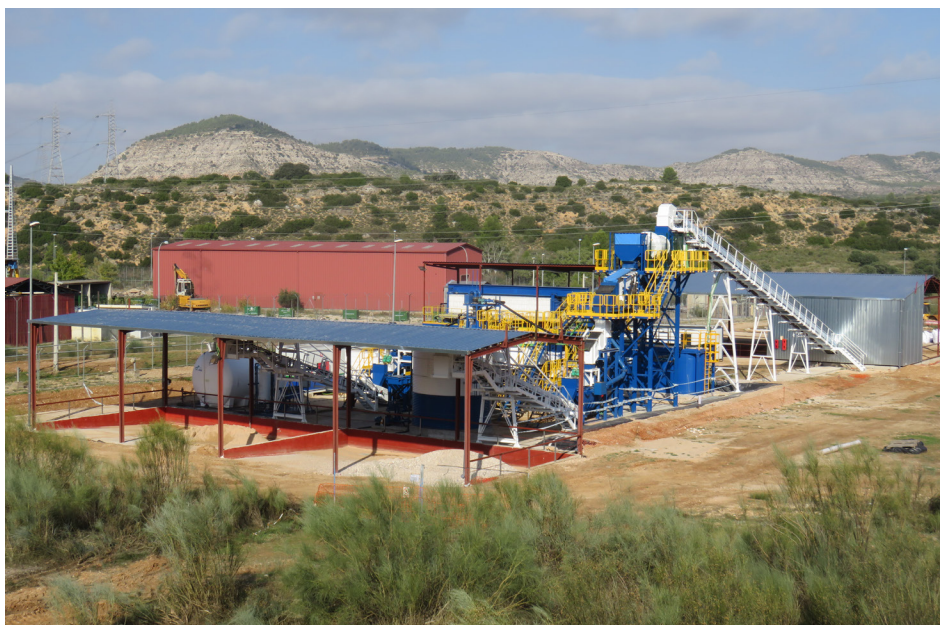
Imagen de la planta para el tratamiento de suelos en la central nuclear de José Cabrera.
