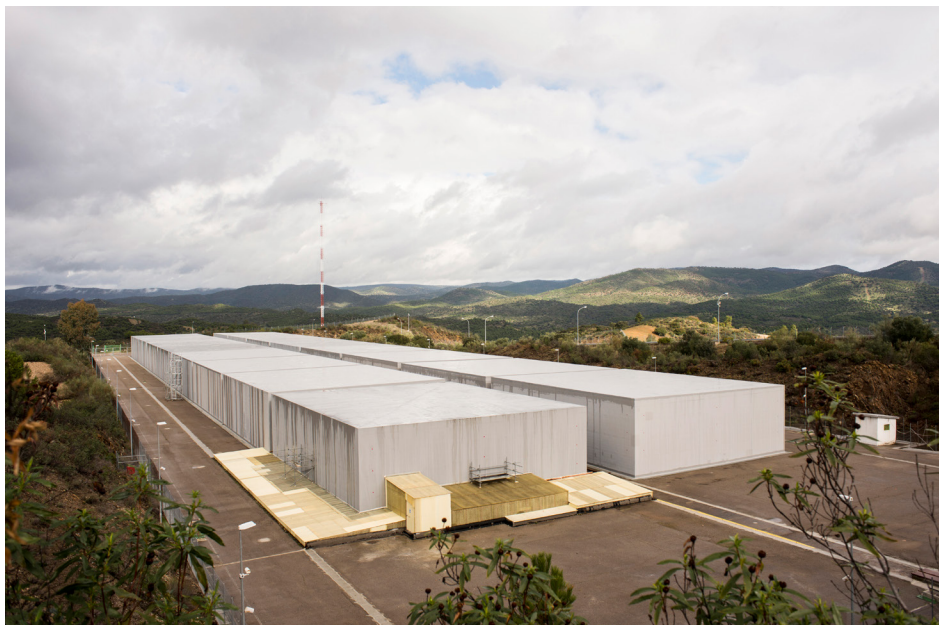
Imagen de las celdas de almacenamiento de RBMA en el C.A. El Cabril.
