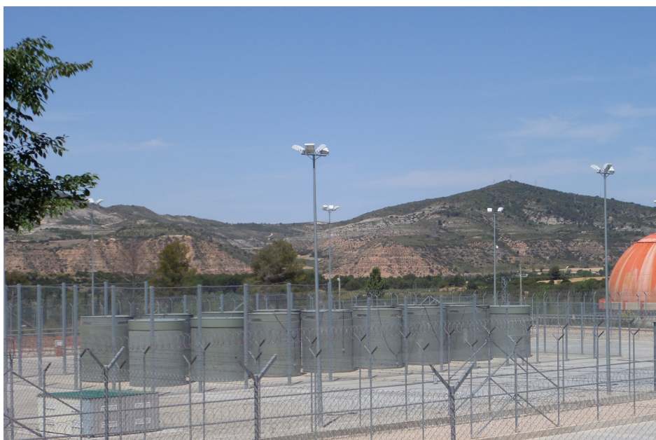
Vista general del ATI de la Central Nuclear José Cabrera.
