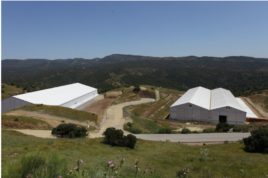
Imagen de las celdas de almacenamiento de RBBA en el C.A.El Cabril.
