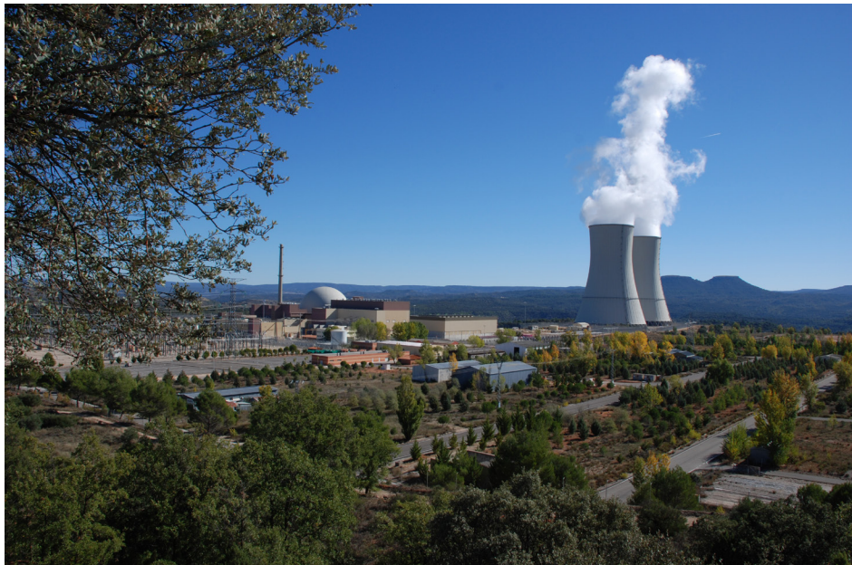
Vista general de la Central Nuclear Trillo.
