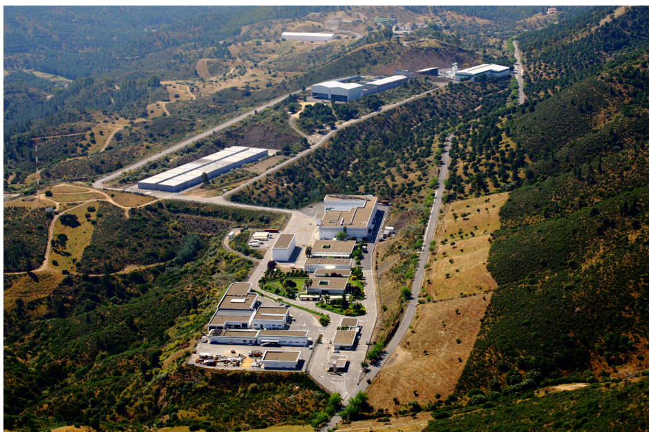
Vista aérea de las instalaciones de almacenamiento definitivo de RBMA del C.A. El Cabril (Córdoba).
