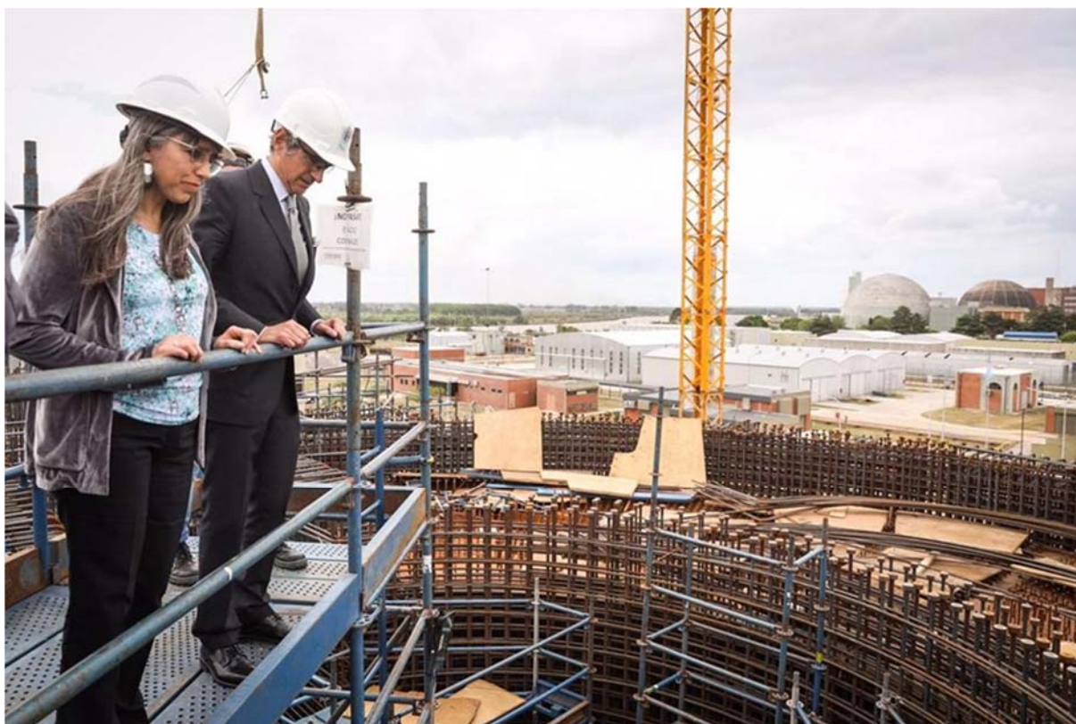
El Director General visita CAREM 25, el primer prototipo de reactor modular pequeño de la Argentina, actualmente en construcción. Octubre de 2022. (Fotografía cortesía de I. Dambrauskas/CAREM)
