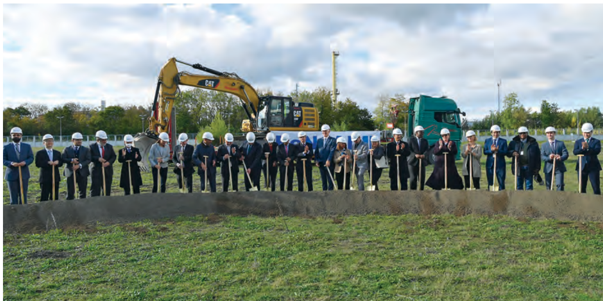
Церемония закладки фундамента нового здания лабораторий в Зайберсдорфе 5 октября 2022 года.
