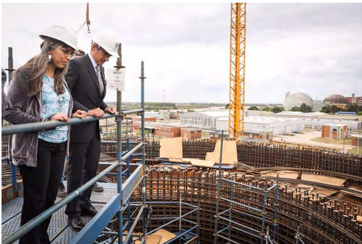
Генеральный директор посещает установку CAREM-25 — первый прототип аргентинского малого модульного реактора, который сейчас находится в стадии строительства, октябрь 2022 года. (Фотография предоставлена И. Дамбраускасом/CAREM)
