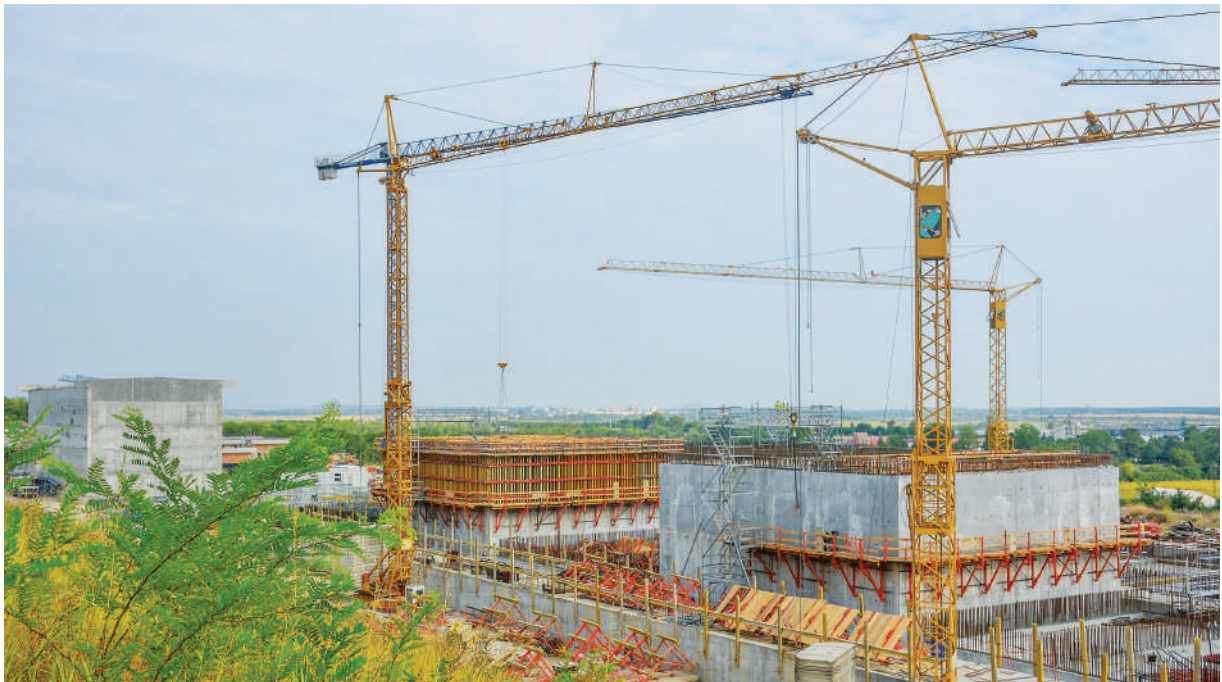
Les participants à la réunion DISPONET ont visité le dépôt national en construction sur le site de Radiana (Bulgarie).
