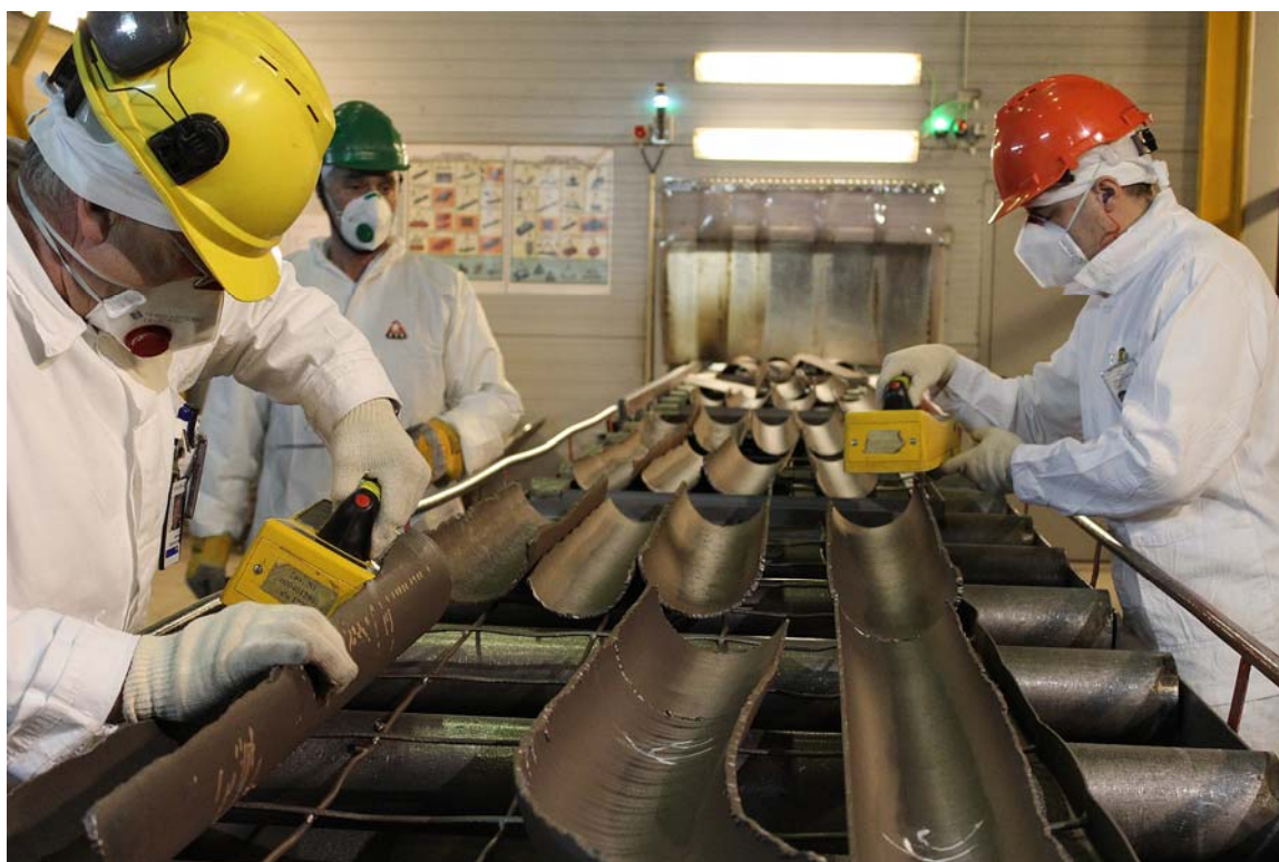
Fig. 2. Trabajadores desmantelan la sala de turbinas en la central nuclear de Ignalina y miden la chatarra en busca de rastros de radiación. (Foto de archivo).
