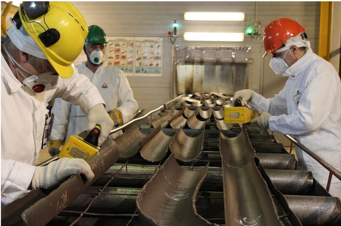
FIG. 2. Des travailleurs qui démantèlent la salle des turbines de la centrale nucléaire d'Ignalina mesurent la ferraille pour repérer les traces de matière radioactive (photo d'archives).
