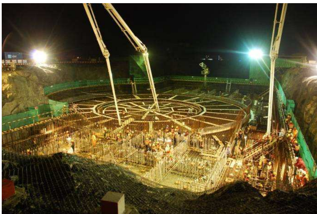
FIG. 1. Coulage du premier béton sur le site du projet de construction de la centrale nucléaire de Sanmen en Chine.
