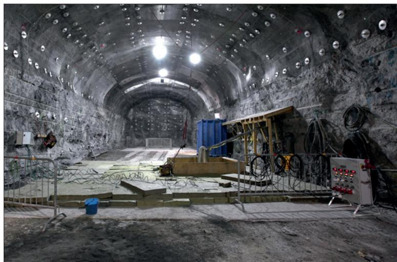
**La instalación de disposición final para combustible gastado ONKALO, que se está construyendo en Olkiluoto (Finlandia), consta de un sistema técnico de túneles. Esta instalación también se utiliza para caracterizar la roca hospedante a fin de contribuir a la elaboración de la justificación de la seguridad.**
