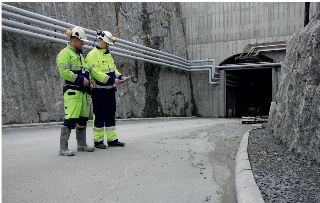
Вход в хранилище отработавшего ядерного топлива "Онкало", Финляндия.
