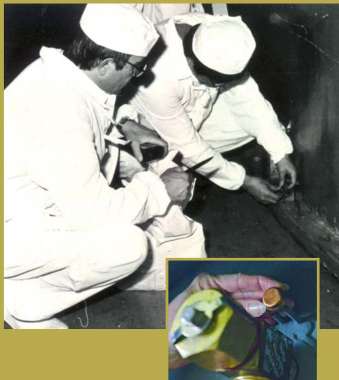
Инспектора МАГАТЭ опечатывают защитную оболочку реактора на АЭС "Козлодуй" в Болгарии. Они наносят специальные печати, защищающие от несанкционированного и незаявленного доступа к ядерному материалу или его тайного изъятия.
