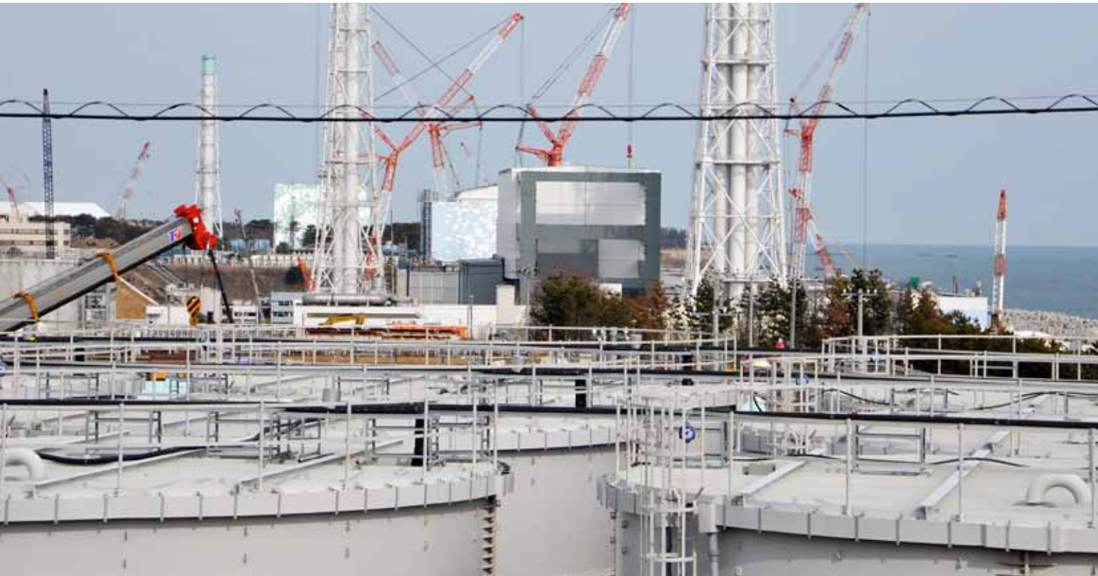
صهاريج مياه تحتوي المياه الملوّثة أمام مباني المفاعل في فوكوشيما دايتشي.
