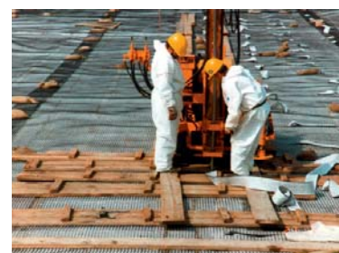
Применение комбинированной схемы для покрытия и дренирования хвостов обогащения урана.
