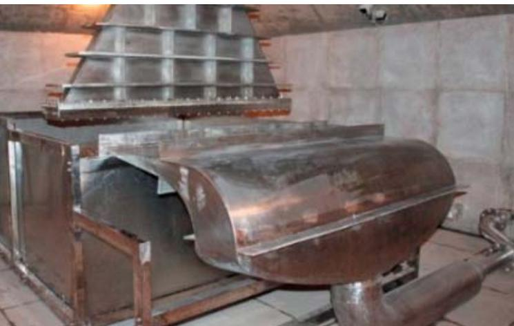
Сточные воды могут подвергаться облучению с помощью высокоэнергетических электронных пучков на станции пучкового сканирования.
