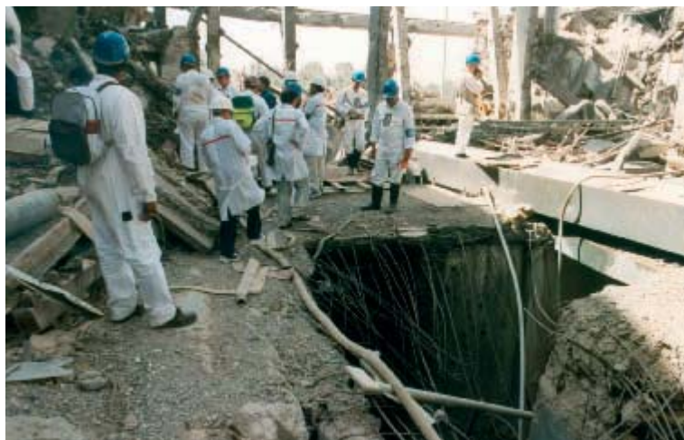
Des inspecteurs de l'AIEA examinent les ruines d'une installation de production d'uranium hautement enrichi (Iraq, 1991-1998).
