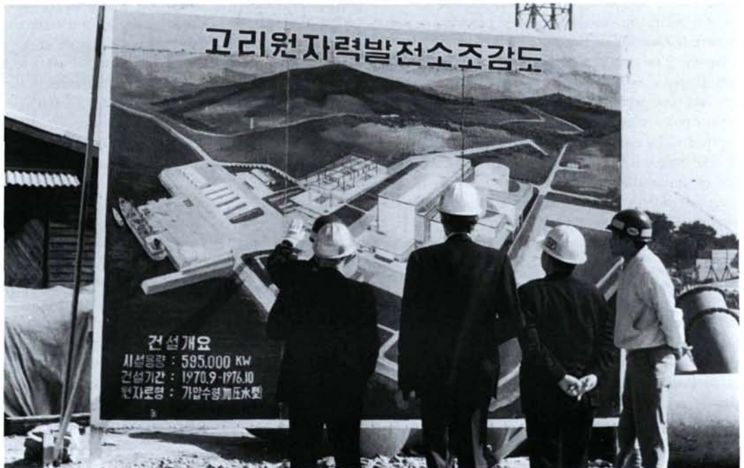
Une équipe examine le plan panoramique de la première centrale nucléaire de la République de Corée, à Kori, en 1974. Le pays possède aujourd'hui neuf réacteurs qui assurent plus de 40% de la production d'électricité du pays.
