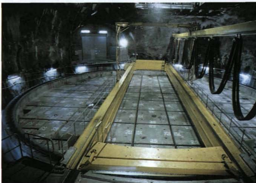
Photo de gauche: Château de combustible irradié mis en position au Centre de recherche nucléaire de Karlsruhe (Allemagne).
