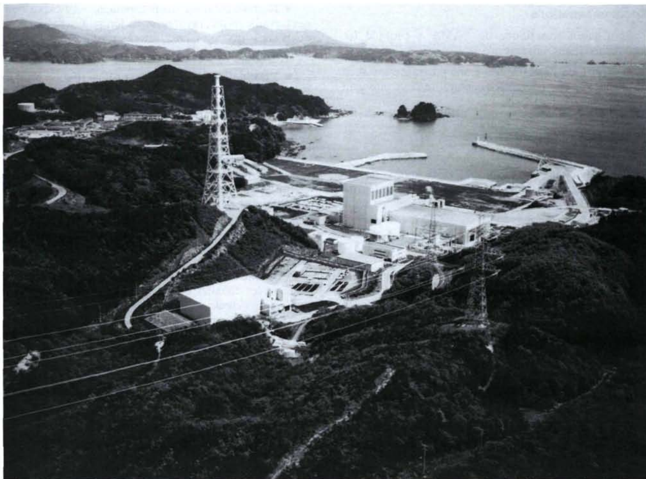
Centrale nucléaire Onagawa (Japon).
