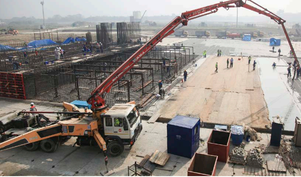
بناء أول محطة قوى نووية في بنغلاديش بدأ في ٣٠ تشرين الثاني/نوفمبر ٢٠١٧.
