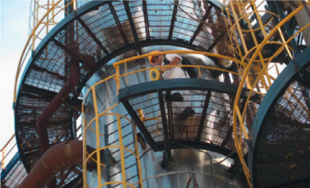
**Especialista del CNESTEN en una refinería de Marruecos aplica la gammagrafía al armazón de una columna de destilación de 75 metros sellado al vacío.**
