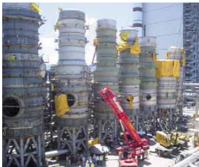
Строительство целлюлозной фабрики. Фото: Комиссия по атомной энергии Чили
