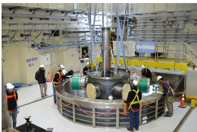
FIG. E.1. Installation du réservoir réflecteur du réacteur de recherche RA-10 au Centre atomique Ezeiza, en Argentine. [Source : Commission nationale de l'énergie atomique (CNEA) (Argentine)]
