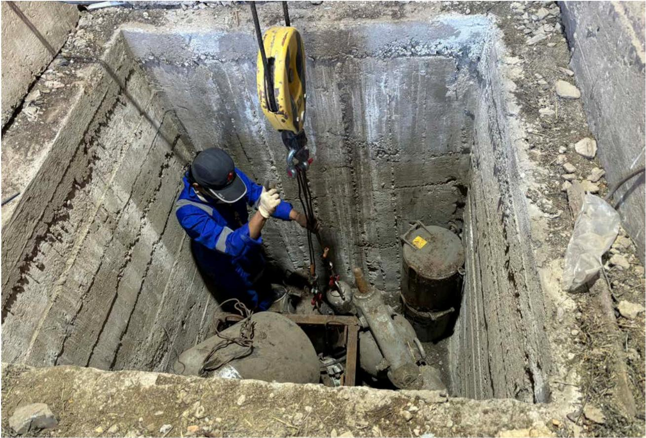
Recuperación de dispositivos que contienen fuentes de  $^{226}\text{Ra}$  de una instalación de almacenamiento subsuperficial en Mongolia.
