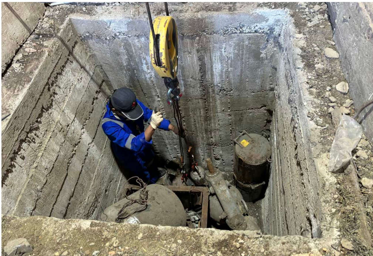
Извлечение устройств, содержащих источники ^{226}\text{Ra} , из подземного пункта хранения в Монголии.
