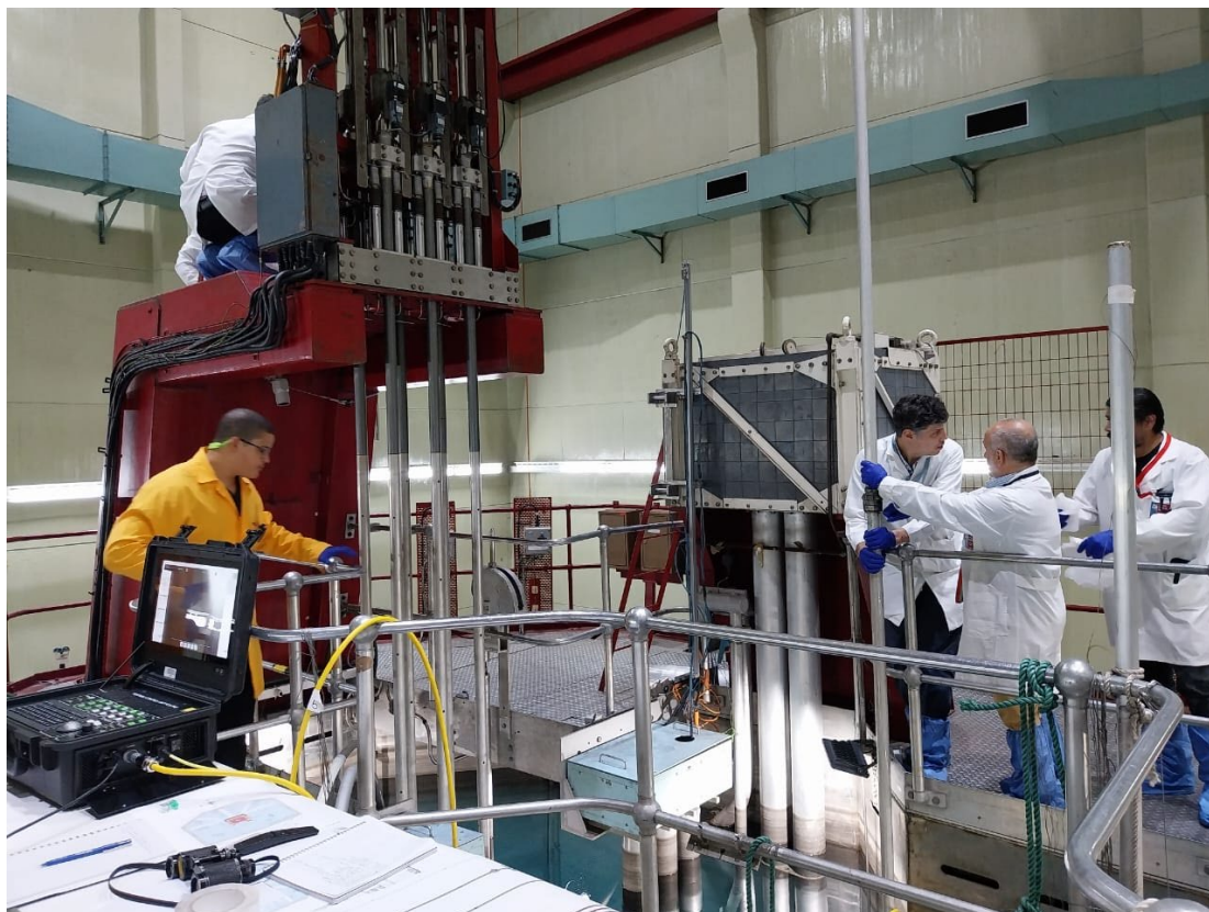
РИС. В.2. Миссия МАГАТЭ в поддержку инспекции в процессе эксплуатации на исследовательском реакторе RECH-1 в Сантьяго, Чили. (Фото: Чилийская комиссия по ядерной энергии)
