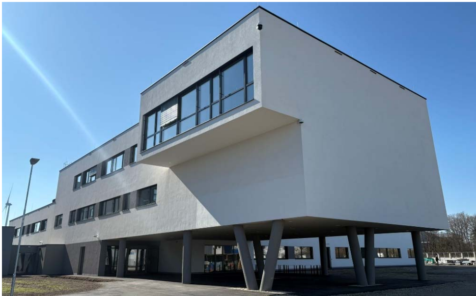
图 B.1. 新实验室大楼（第二个移动模块实验室）的外墙。 （图片来源：原子能机构）
