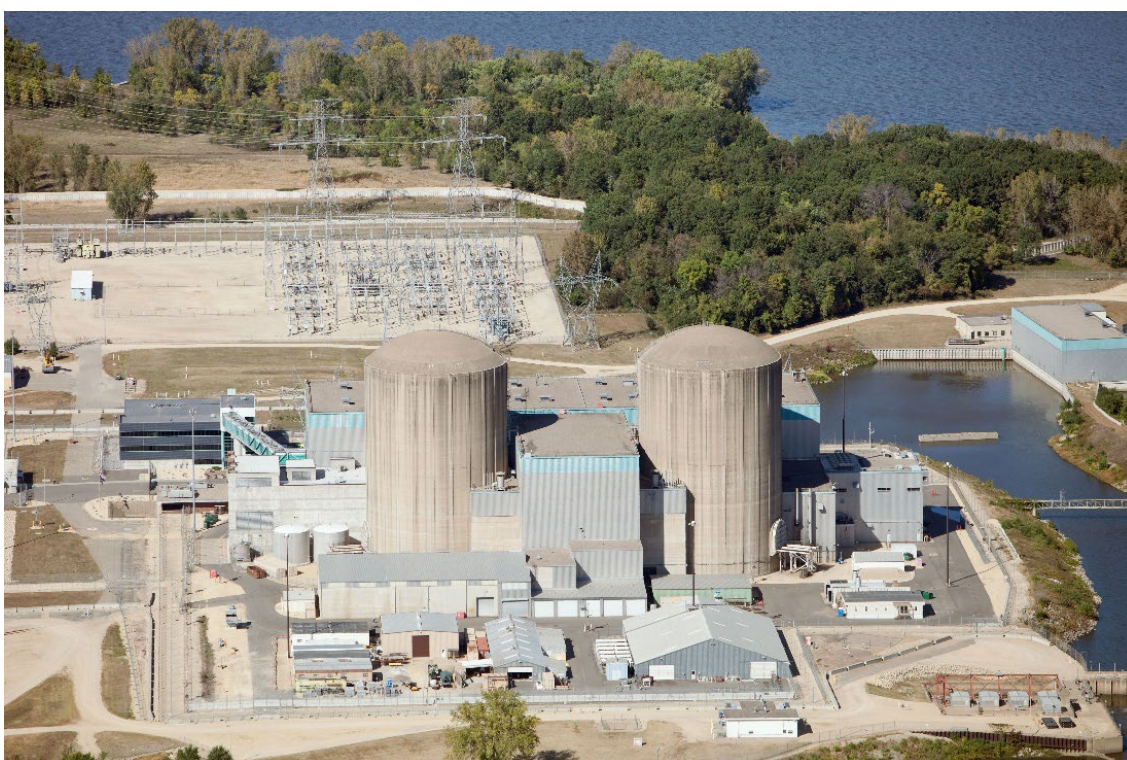
图 A.4. 位于美利坚合众国明尼苏达州的普雷里岛核电厂，埃克西尔能源公司和合作伙伴正在那里部署一个使用高温蒸汽电解装置的试点制氢项目。
