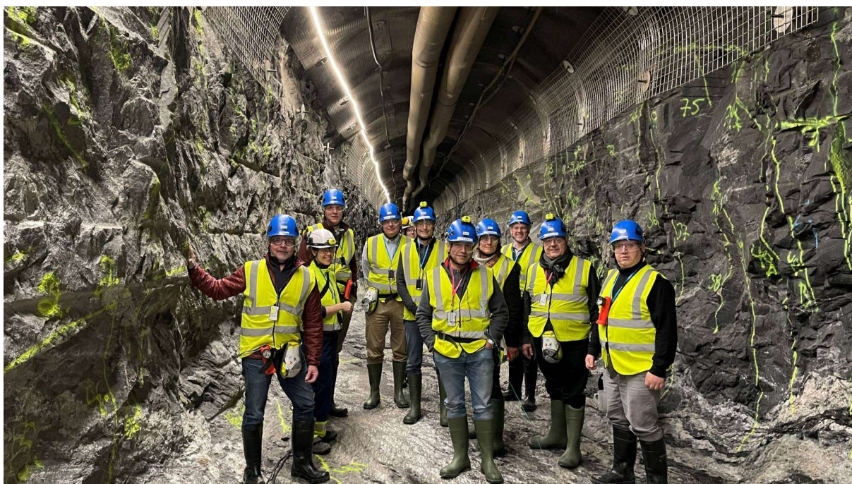
L'équipe ARTEMIS en visite à l'installation de stockage en formations géologiques profondes de combustible usé d'Onkalo (Finlande) en décembre 2022.
