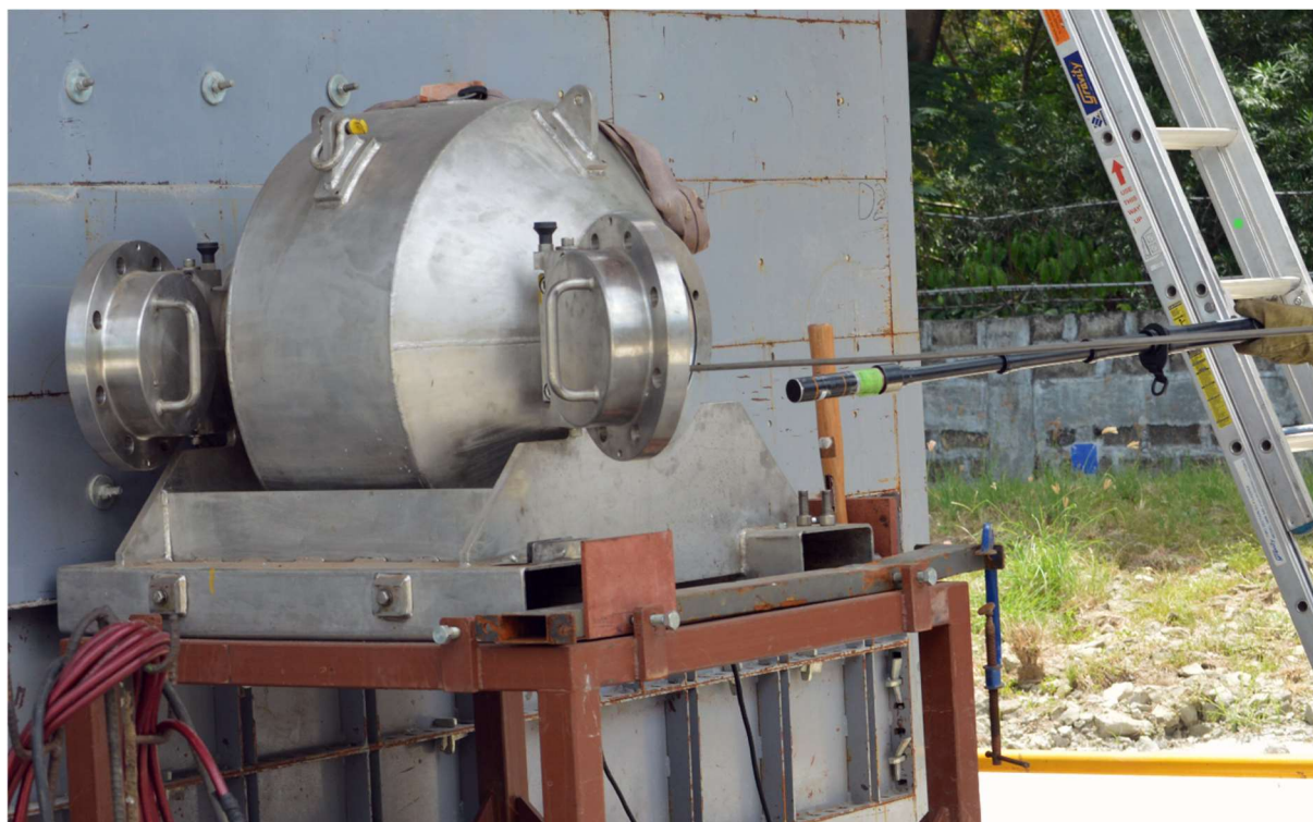
Enlèvement d'une source gamma vers une cellule chaude mobile.
