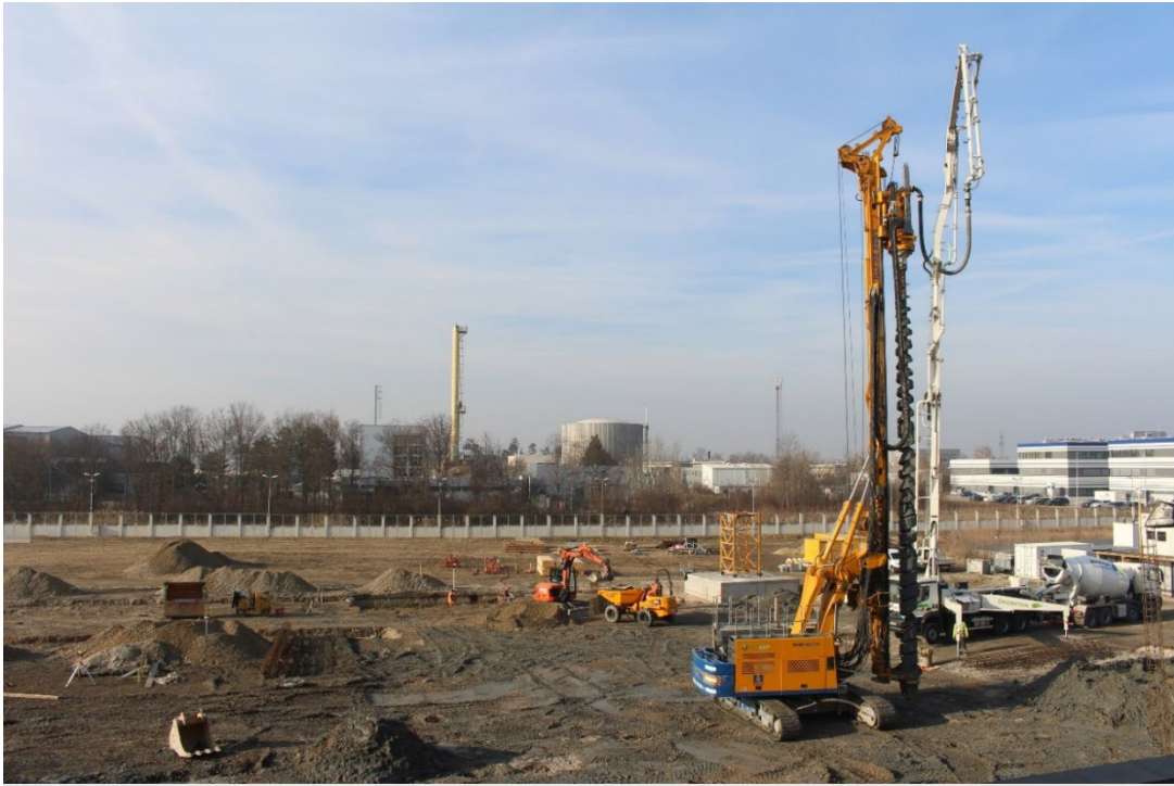
图 B.2. 截至 2023 年 2 月新实验室大楼和温室地基的施工状况。 (照片来源：原子能机构)
