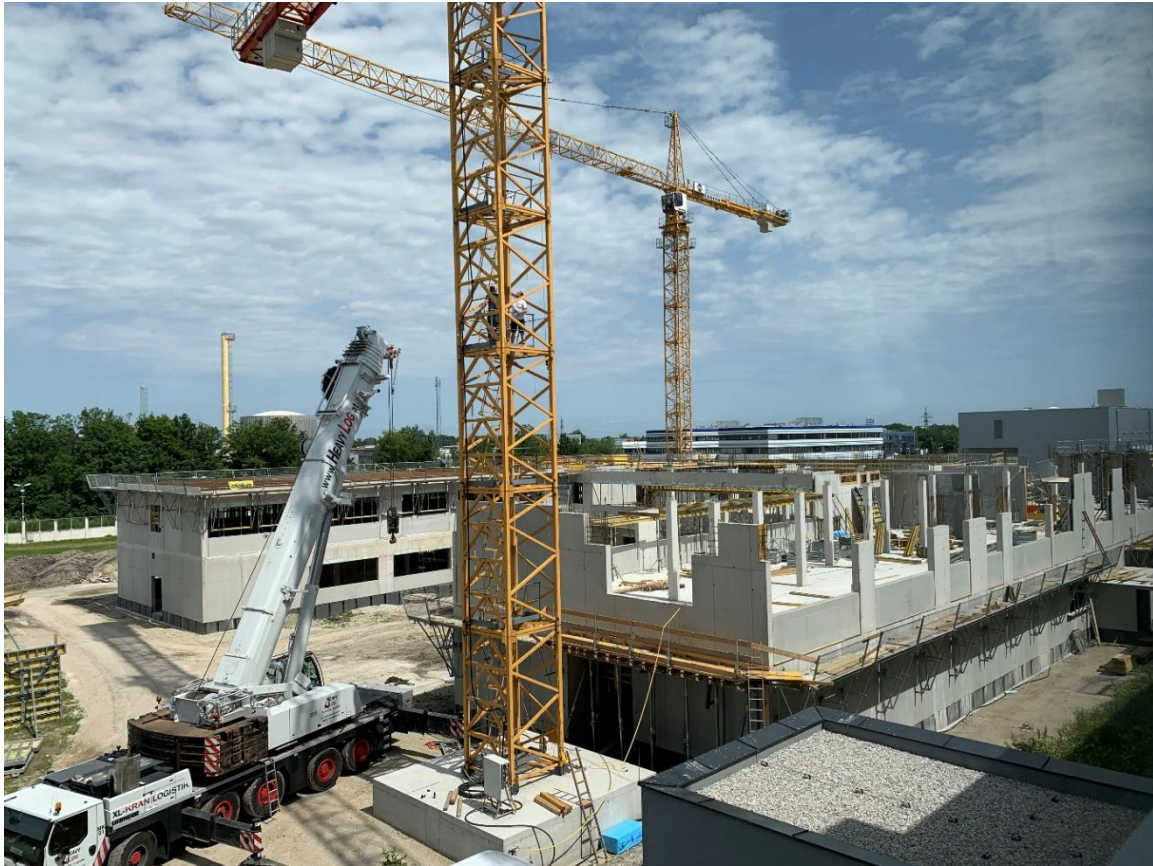
图 B.4. 截至 2023 年 6 月底新实验室大楼和温室地基的施工状况。
