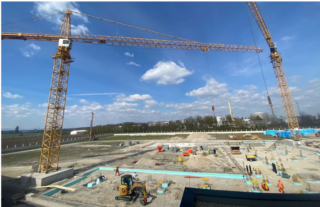
图 B.3. 截至 2023 年 4 月新实验室大楼和温室地基的施工状况。 (照片来源：原子能机构)
