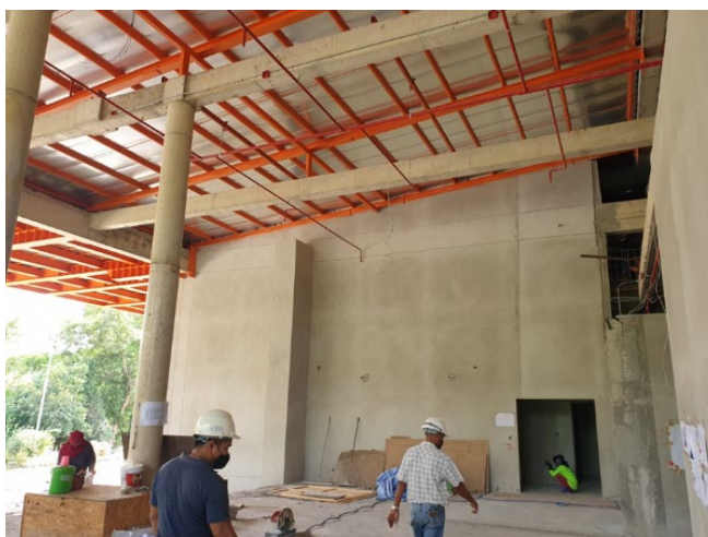
Obras en el edificio del complejo del ciclotrón. (Fotografía: Dr. Kanokporn Boonsirichai, Instituto de Tecnología Nuclear de Tailandia)
