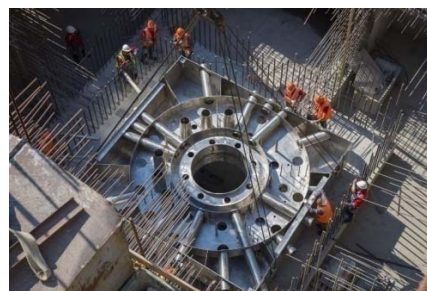
Fig. D-1 c. Instalación de piso de losa en la base de la cavidad del reactor MBIR. Instituto de Investigación de Reactores Atómicos, Centro Científico Estatal, Dimitrovgrad (Federación de Rusia) (Fotografía: Rosatom)
