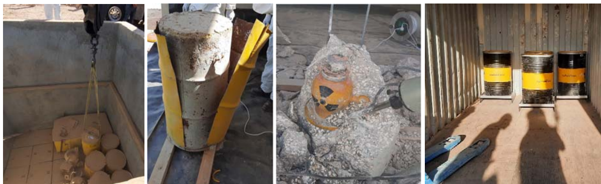
Fig. C-4. Recuperación de fuentes radiactivas y acondicionamiento en nuevos bultos de desechos en un emplazamiento de almacenamiento de desechos heredados en Jordania. (Fotografías: Comisión de Energía Atómica de Jordania)
