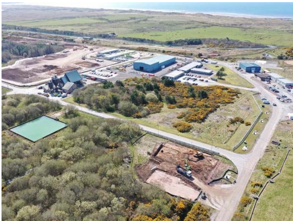
Fig. C-3. Actividades preparatorias en el repositorio de desechos de actividad baja del Reino Unido para apoyar la colocación de la cubierta definitiva sobre parte de la instalación. (Fotografía: Autoridad de Clausura de Instalaciones Nucleares del Reino Unido, 2021)
