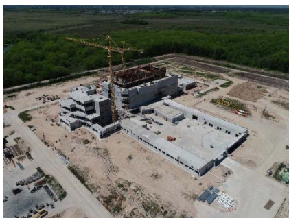
Fig. D-1 a. Construcción del reactor de investigación RA-10 en el Centro Atómico Ezeiza de la Argentina. (Fotografía: CNEA)
