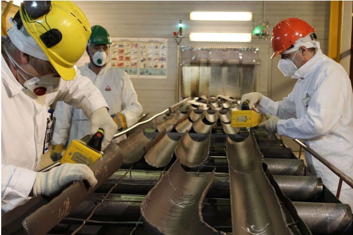
Trabajadores desmantelan la sala de la turbina de la central nuclear de Ignalina y realizan mediciones de la chatarra a fin de detectar trazas de radiación. (Fotografía: J. Donovan/OIEA).
