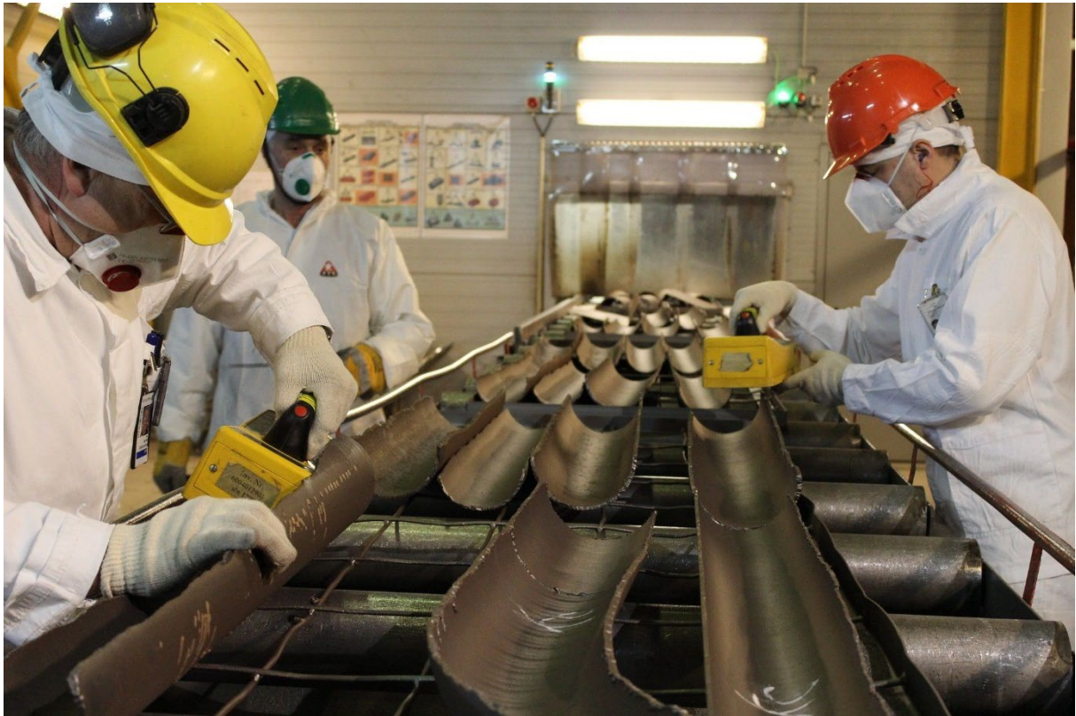
伊格纳林纳核电厂拆除汽轮机大厅的工作人员在探测废金属是否有放射性 (照片来源：J. Donovan/原子能机构)
