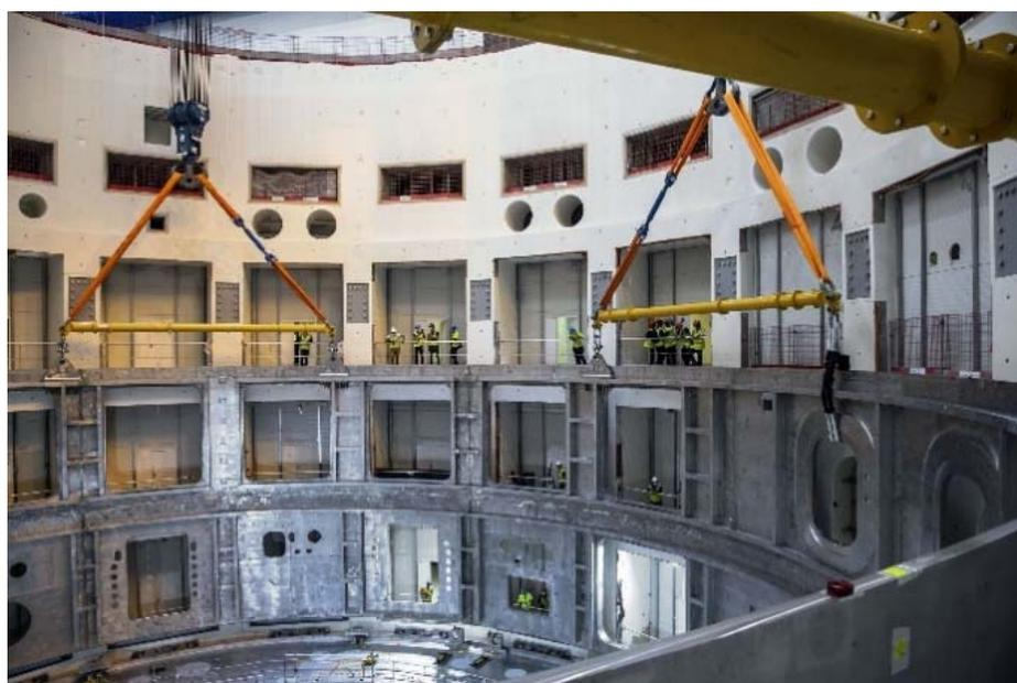
*РИС. А-6. После установки основания криостата в шахту был спущен его нижний цилиндр массой 375 тонн. Затем цилиндр был приварен к основанию. (Фото: Организация ИТЭР)*
