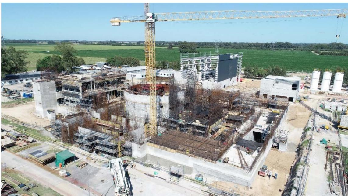
*РИС. А-2. Реактор CAREM, строительство которого идет полным ходом на площадке, прилегающей к АЭС «Атуга»/«Нестор Карлос Киришер» в Аргентине. Ввод в эксплуатацию запланирован на 2024 год. Мощность при работе в качестве демонстрационного прототипа составит 30 МВт (эл.).
