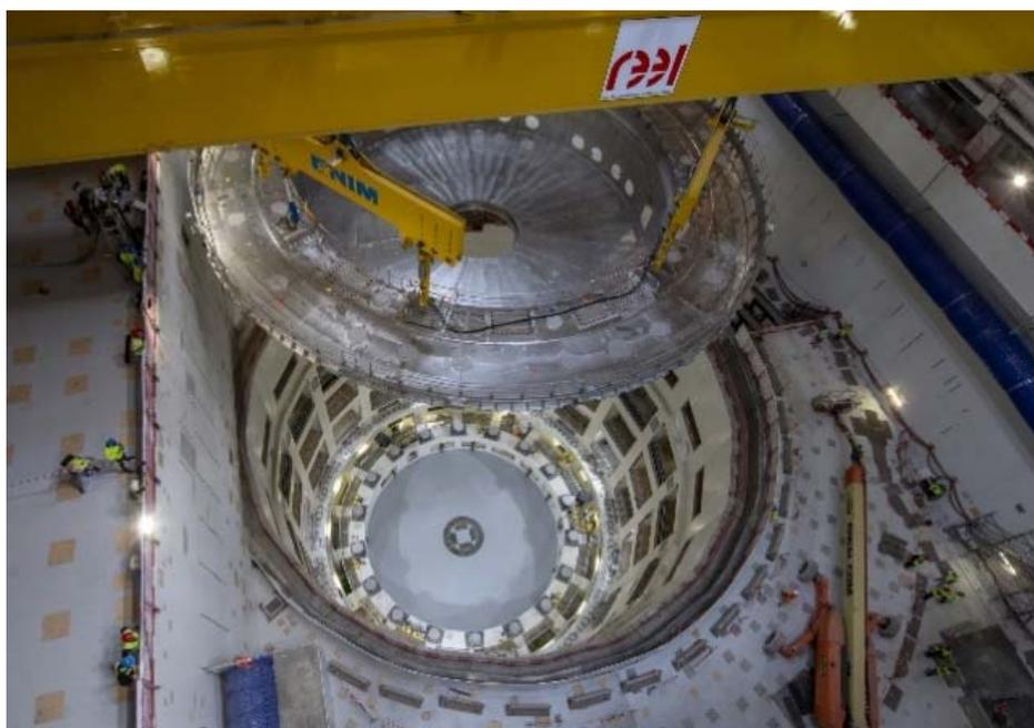
*РИС. А-5. Основание криостата массой 1250 тонн стало первым крупногабаритным компонентом, установленным в нижней части шахты токамака глубиной 30 метров. (Фото: Организация ИТЭР)*
