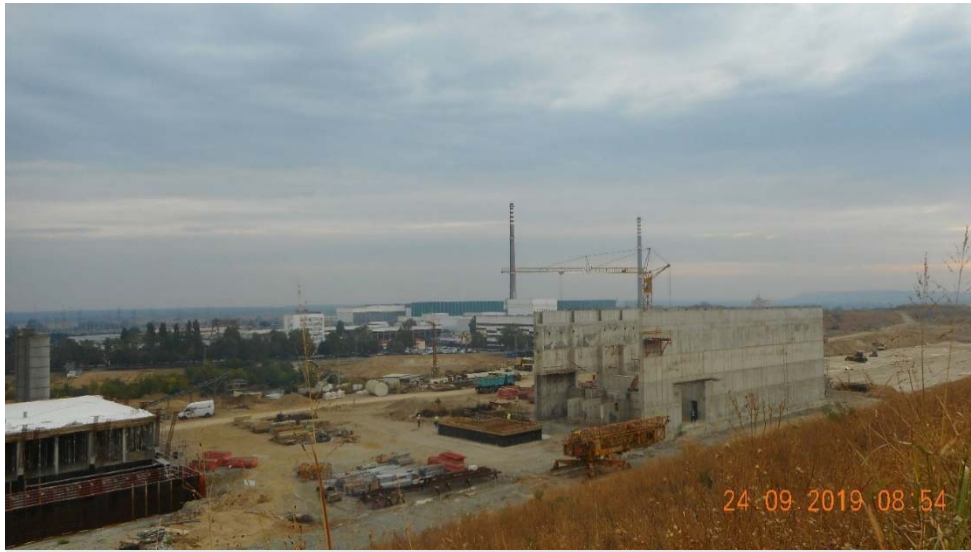
الشكل ألف-١٧- تشييد المرفق الوطني للتخلص في موقع راديانا بالقرب من محطة كوزلودوي للقوى النووية تُظهر المجمع المعني بالإدارة (يساراً)، ومبنى منطقة استقبال النفايات ومنطقة التخزين العازلة (يميناً)، وأساس منصة التخلص ١ المُشيد بأسمنت-طفلة اللوس (أقصى اليمين).
