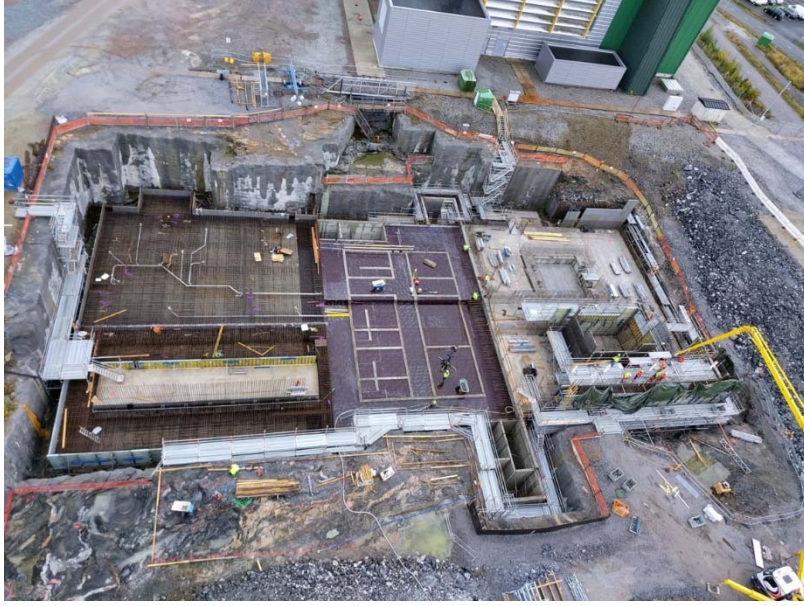
الشكل ألف-١٦ - تشييد محطة Posiva لتغليف الوقود النووي المستهلك. (الصورة من: شركة Posiva)
