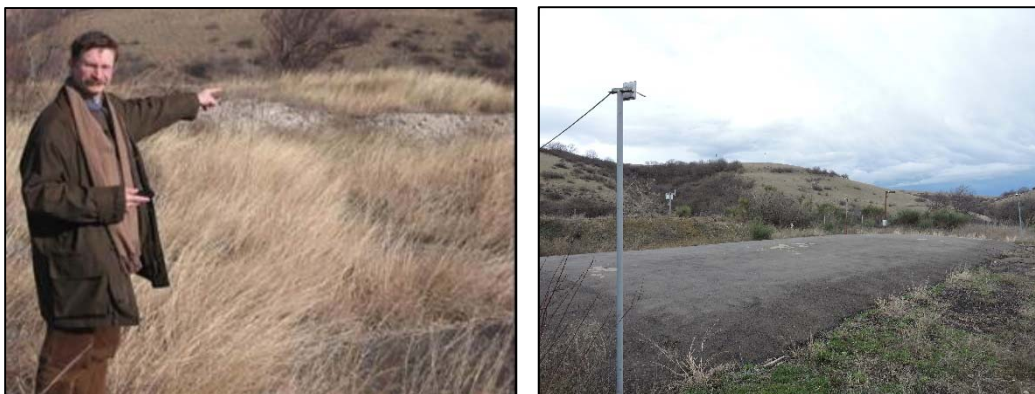
GEO9013. Объект Саакадзе: вид на заброшенный пункт захоронения в 2005 году (слева) и вид на новое покрытие пункта в 2017 году (справа). Фото: М. Ожован/МАГАТЭ, Г. Набахтиани/Агентство по ядерной и радиационной безопасности, Грузия
