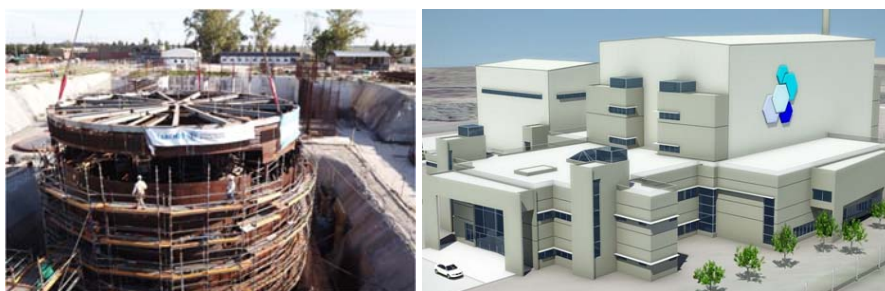
РИС. В-3. Строительство реактора «CAREM-25» (слева); окончательный макет установки (справа). Фото: НКАЭ, Аргентина.
