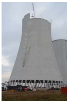
РИС. А-6. Снос градирен АЭС «Богунце-V1», Словакия, октябрь 2017 года. (Фото: JAVYS)
