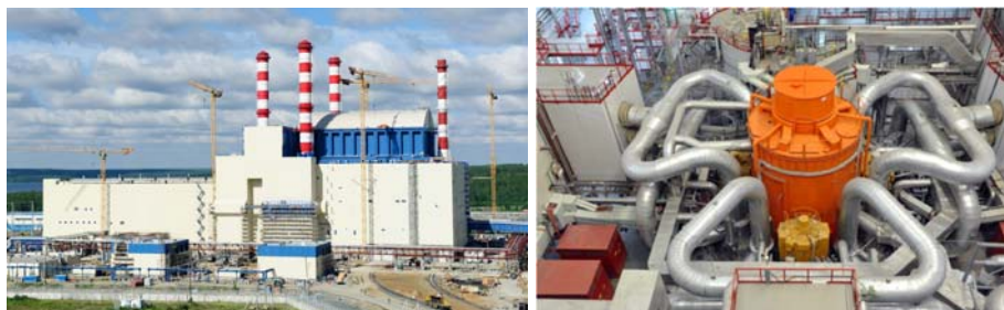
Рис. В-2. Реактор БН-800 с натриевым теплоносителем был сдан в промышленную эксплуатацию 31 октября 2016 года. (Фото: «Росэнергоатом»)
