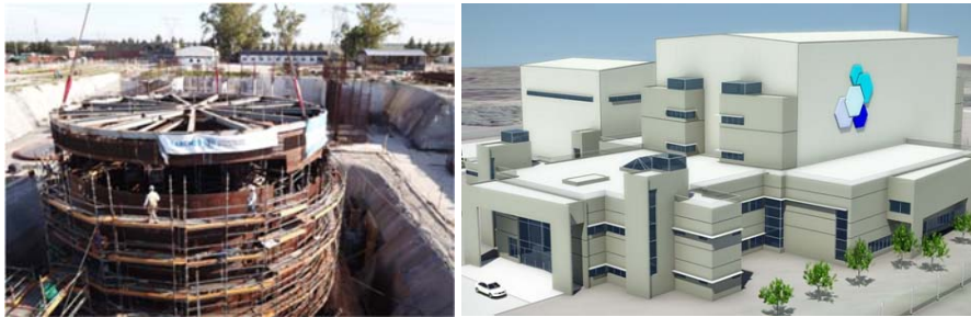
الشكل- باء-٣- المفاعل CAREM-25 قيد الإنشاء (إلى اليسار)؛ التخطيط النهائي للمحطة (إلى اليمين). (الصور من: الهيئة الوطنية للطاقة الذرية، الأرجنتين)
