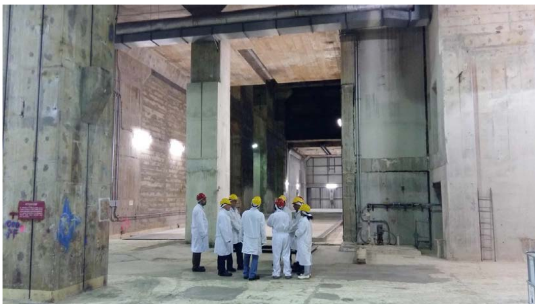
FIG. 1. Des membres de l'équipe ARTEMIS et du personnel de l'entreprise publique italienne SOGIN visitent la centrale nucléaire de Caorso, dans le nord de l'Italie, dans le cadre du premier examen ARTEMIS de l'Agence.
