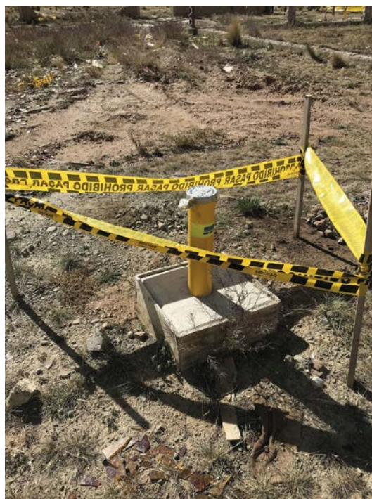
FIG. 1. L'un des puits de forage géologique construits pour la caractérisation du site du nouveau réacteur de recherche de 200 kW, à El Alto (Bolivie).
