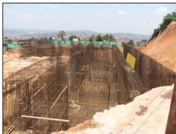
Chantier de construction de six nouvelles casemates à l'Institut du cancer ougandais, inauguré en juin 2016.
