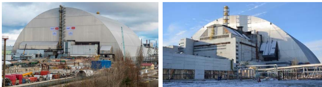
FIG. A-6. La nouvelle enveloppe de confinement sûr construite au-dessus de la tranche 4 de la centrale nucléaire de Tchernobyl (à gauche, vue depuis le site de construction ; à droite, vue depuis la tranche 3). La structure est haute de 108 mètres, longue de 162 mètres et large de 257 mètres. Elle pèse environ 36 000 tonnes. (Photos : centrale nucléaire de Tchernobyl)
