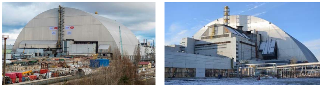
图 A-6. 切尔诺贝利核电站 4 号机组的新安全封隔设施（左，建造场址视图；右，3 号机组视图）。该结构高 108 米，长 162 米，宽 257 米，重约 3.6 万吨。（图片：切尔诺贝利核电站）
