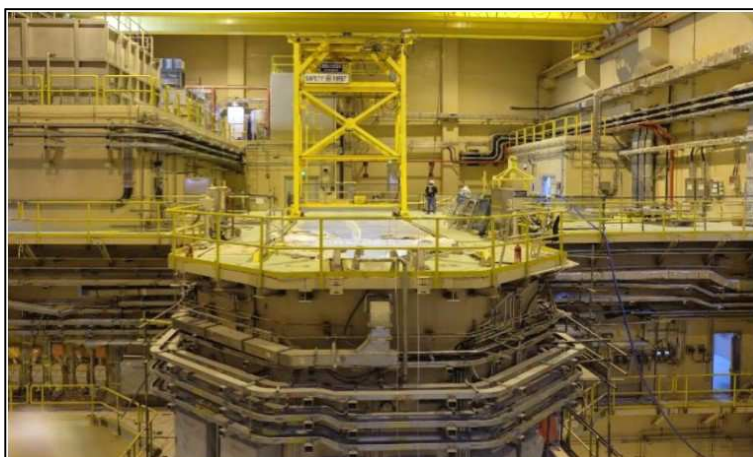
JOR/1/005 : Réacteur jordanien de recherche et de formation en construction à Irbid (Jordanie).
