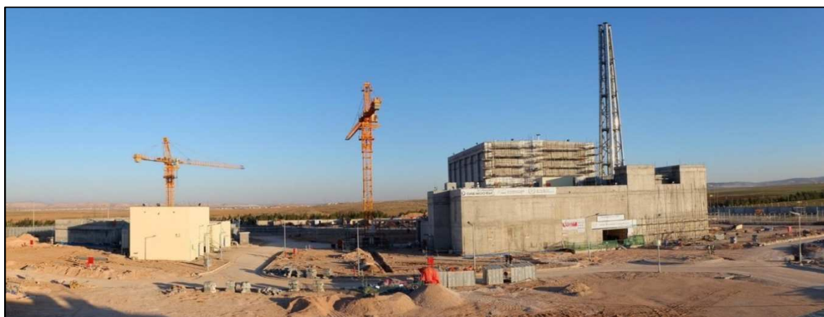
Site de la centrale nucléaire jordanienne en chantier.
