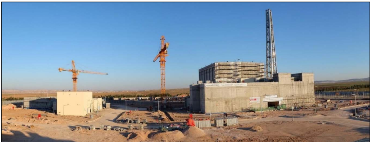
正在建设的约旦核电厂场址。
