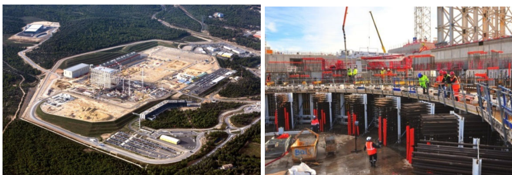
FIG. B-6. Vue aérienne du site de construction d'ITER en août 2015 (à gauche). Le 21 octobre 2015 (à droite), le segment de 200° du bouclier de protection thermique, l'« anneau » de 3,2 mètres d'épaisseur qui entourera la machine était construit (Photos : ITER).
