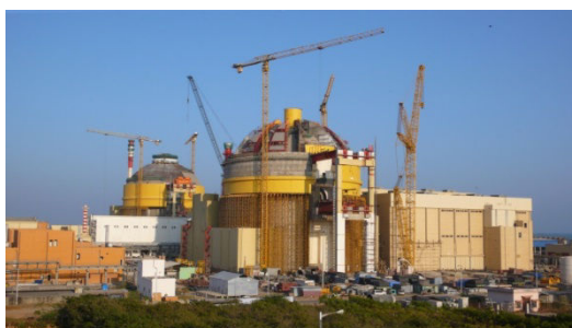
FIG. B-1. Centrales nucléaires équipées de réacteurs VVER-1000 en construction sur le site nucléaire de Kudankulam. (Photo : AIEA)
