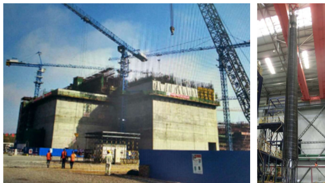
FIG. B-3. Site de construction (à gauche) et le générateur de vapeur (à droite) du HTR-PM dans la baie de Shidao, à Weihai (Chine) (Photos : Institut de technologie de l'énergie nucléaire et des énergies nouvelles)
