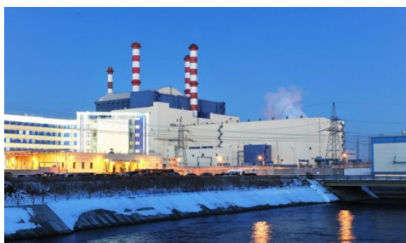
FIG. B-2. Le réacteur commercial à neutrons rapides BN-800 de la centrale nucléaire de Beloyarsk (Fédération de Russie) a été couplé au réseau en décembre 2015. (Photo : Rosenergoatom)
