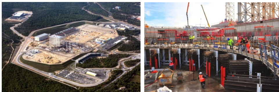
图 B-6. 国际热核实验堆建设工地 2015 年 8 月鸟瞰图（左）。截至 2015 年 10 月 21 日（右），国际热核实验堆生物屏蔽（将环绕机器的 3.2 米厚的“环”）的 200 度段已完工。（照片：国际热核实验堆提供）
