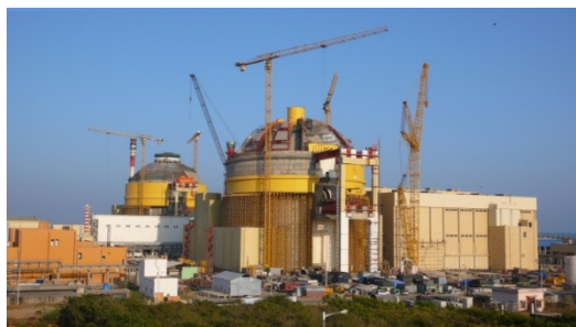
الشكل باء-١ مفاعل مبرد ومهدأ بالماء-محطة قوى نووية بقدرة ١٠٠٠ قيد التشييد في موقع كودانكولام النووي. (الصورة من: الوكالة الدولية للطاقة الذرية)
