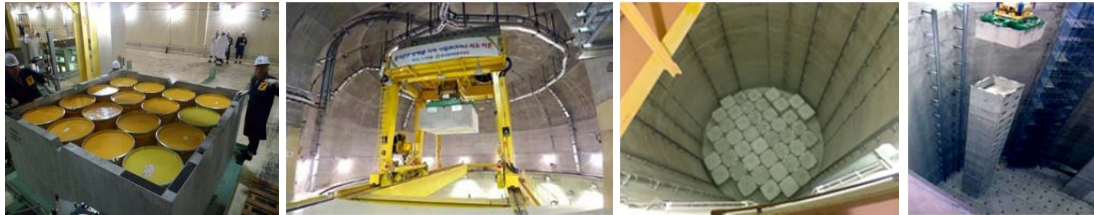
الشكل ألف-٨- حاويات النفايات وأنشطة التخلص الأولى في مستودع Wolsong (الصور من: الوكالة الكورية للنفايات المشعة)
